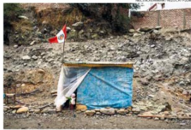
Riesgo. Mucha gente, en su mayoría migrantes que han llegado recién a Huaraz, se ha asentado a orillas del río, lo que pone sus vidas en peligro.
