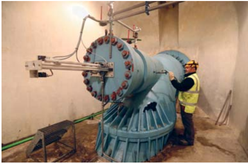
Conduites d'eau Grande Dixence
