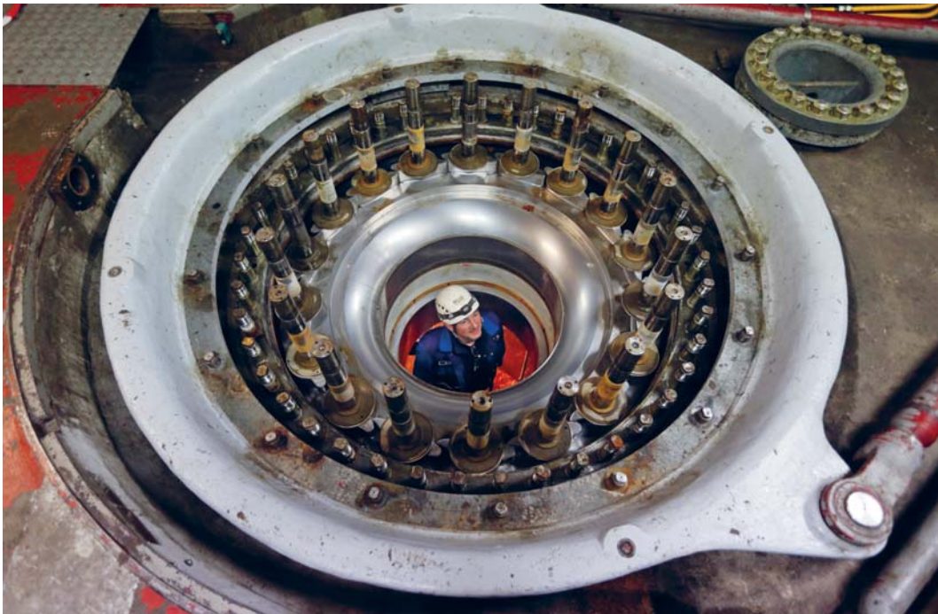
A l'intérieur de la turbine Centrale électrique de St-Léonard, Sierr
