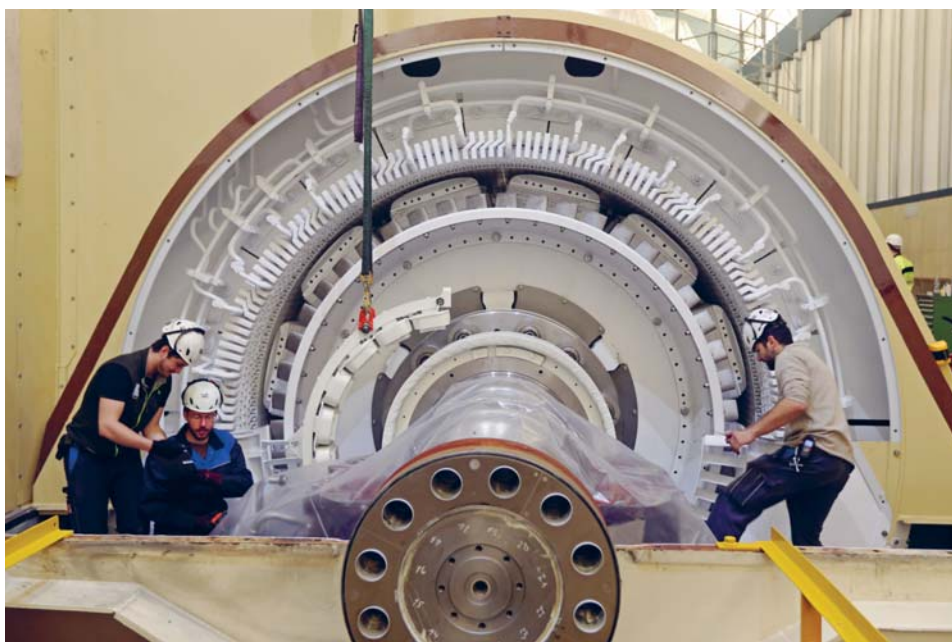
Réparation de turbine Centrale électrique de Nendaz
