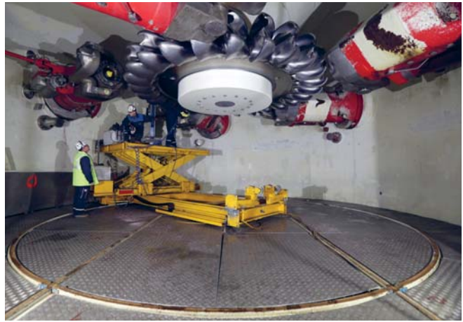
A l'intérieur de la chambre de la turbine Bieudron
