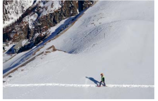
A l'extérieur du barrage Grande Dixence
