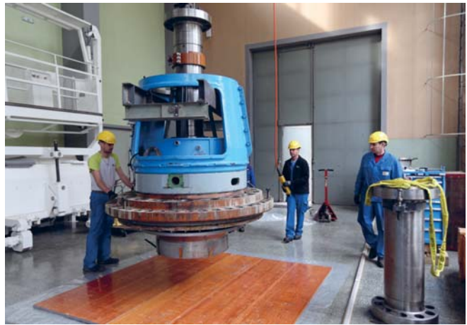
Réparation de turbine Centrale électrique de St-Léonard, Siere
