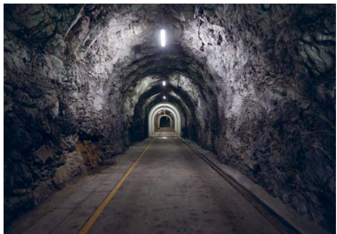
Dans la montagne Centrale électrique de Lavey
