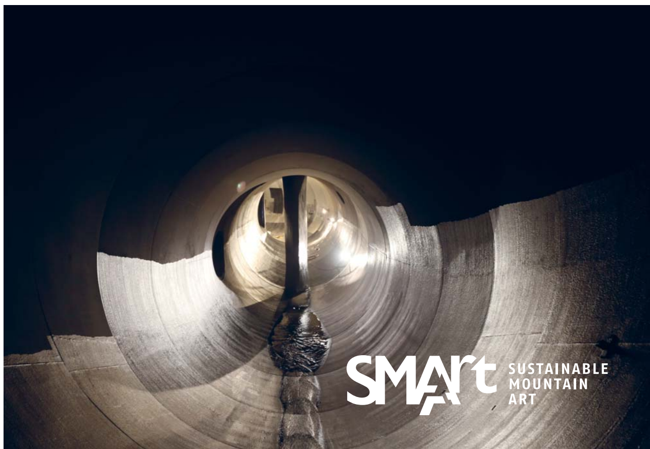
A l'intérieur de la conduite d'eau Centrale électrique de Lavey
