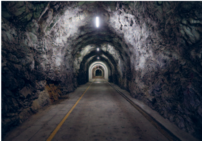
Dans la montagne Centrale électrique de Lavey
