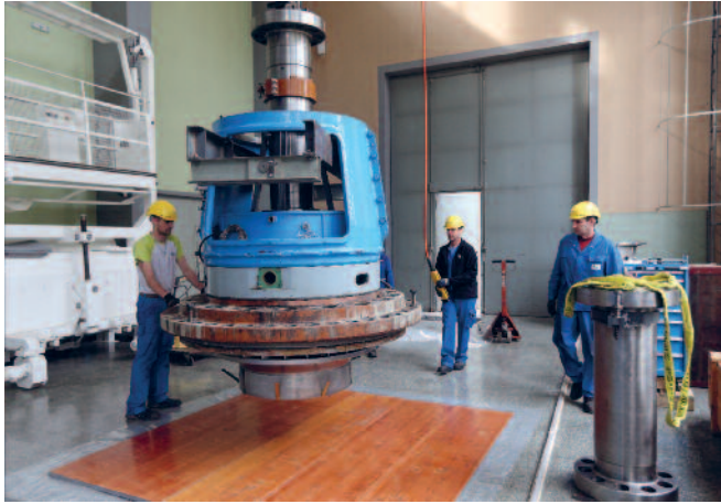
Réparation de turbine Centrale électrique de St-Léonard, Sierre
