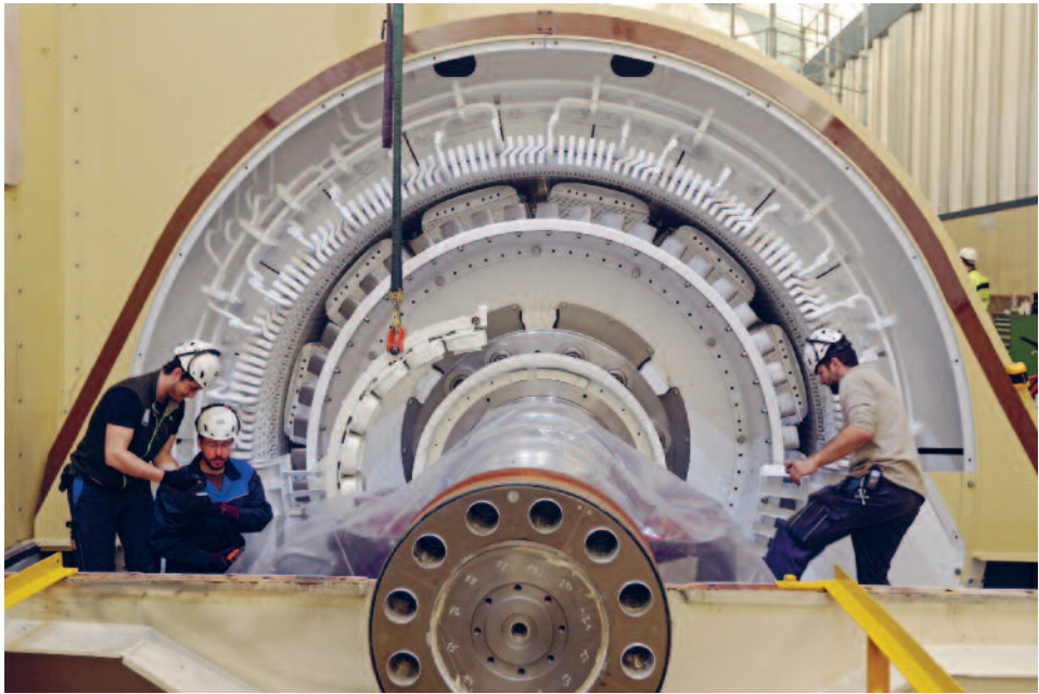
Réparation de turbine Centrale électrique de Nendaz
